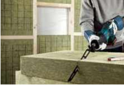
Elyafli yalıtım malzemelerini uzunluğuna veya enlemesine kesmek için hassas ve düz kesimler
